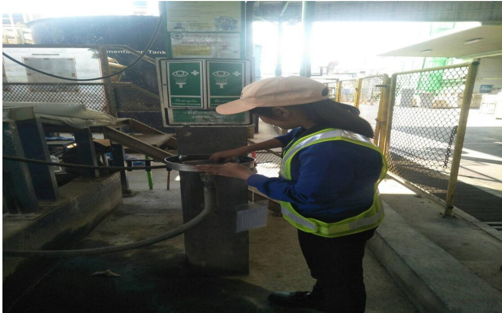
ภาพการตรวจเช็คอ่างล้างตาฉุกเฉิน
