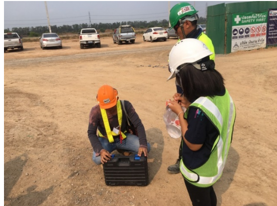
ภาพที่ 1-10 ตรวจสอบคู่มืออุปกรณ์ไฟฟ้าและเครื่องจักร
