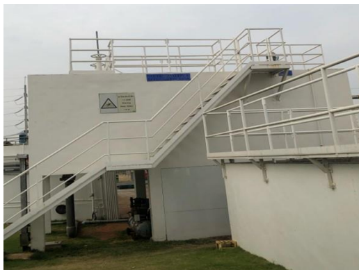
รูปที่ 2.10 แสดงบ่อเติมสารอาหาร (Neutralization & Attenuation Tank)
