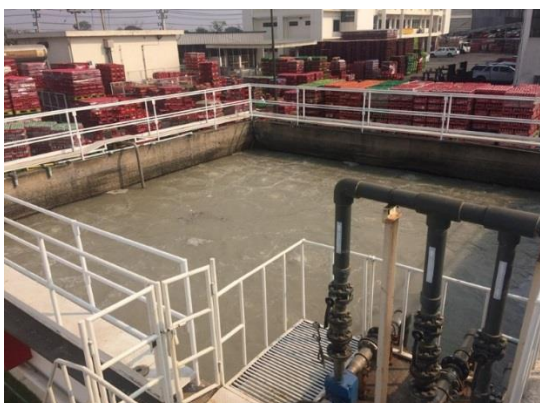
รูปที่ 2.9 แสดงบ่อปรับเสถียร (Equalization Tank)
