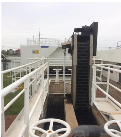
รูปที่ 2.7 แสดงลักษณะของตะแกรง (Screening)
