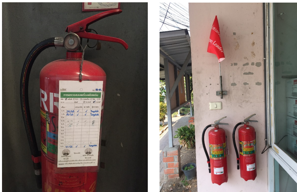
ภาพการตรวจถังดับเพลิง ประจำเดือน ธันวาคม 2562 - กุมภาพันธ์ 2563
