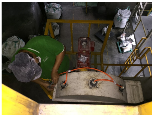
ภาพที่ 2-3 จุดติดตั้งฟิตติ้งในการทดลองครั้งที่ 1 ทั้งหมด 3 จุด
