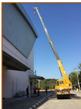
ภาพ 1-13 ผู้รับเหมาเข้าปฏิบัติงานเปลี่ยนหลังคาโปร่งแสง
