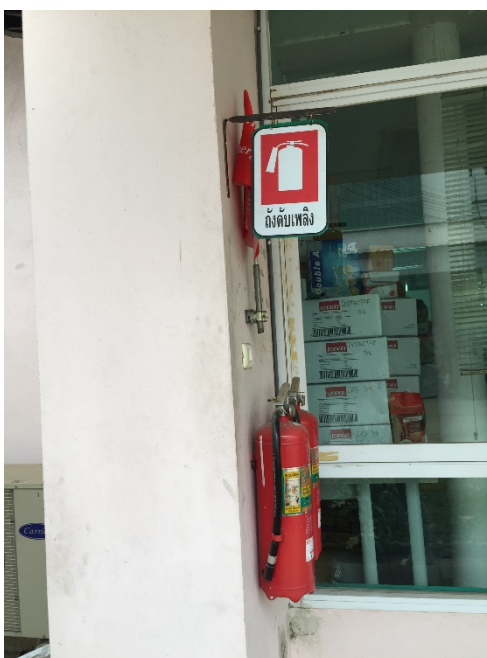
ติดตั้งป้ายสัญลักษณ์ถังดับเพลิง และตะขอเกี่ยวถังดับเพลิง
