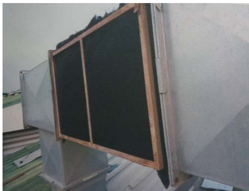
ภาพที่ 2-5 ลักษณะอุปกรณ์กรองอากาศ (Air Filter)
