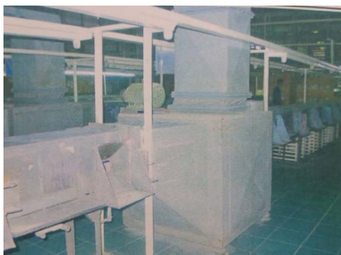
ภาพที่ 2-4 ลักษณะพัดลม ชนิด Centrifugal fan แบบกล่อง (Cabinet Fan, พัดลมตู้)
