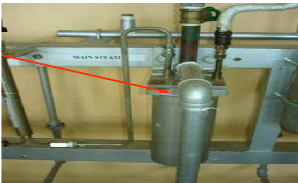
ภาพที่ 2.23 วาล์วทดสอบน้ำ
