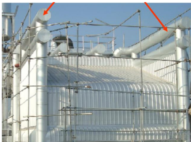
ภาพที่ 2.8 ท่อไอน้ำ
