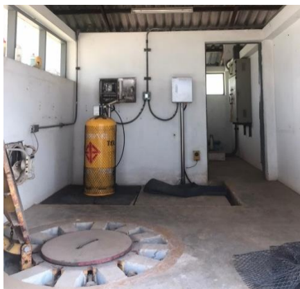
รูปที่ 2.5 โรงจ่ายคลอรีน
