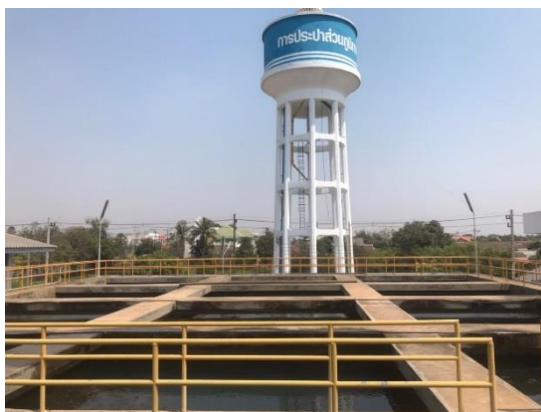
รูปที่ 2.6 หอถังสูง
