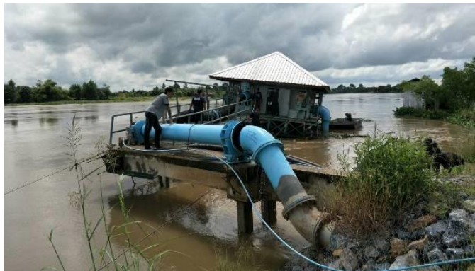
รูปที่ 2.1 โรงสูบน้ำแรงต่ำ
