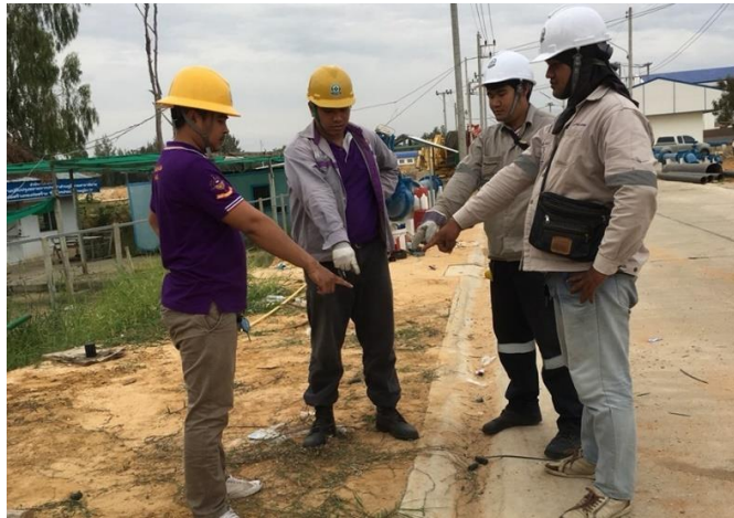
ภาพที่ 2-4 กิจกรรม KYT หม้อแปลงบ้านท่าสงกรานต์
