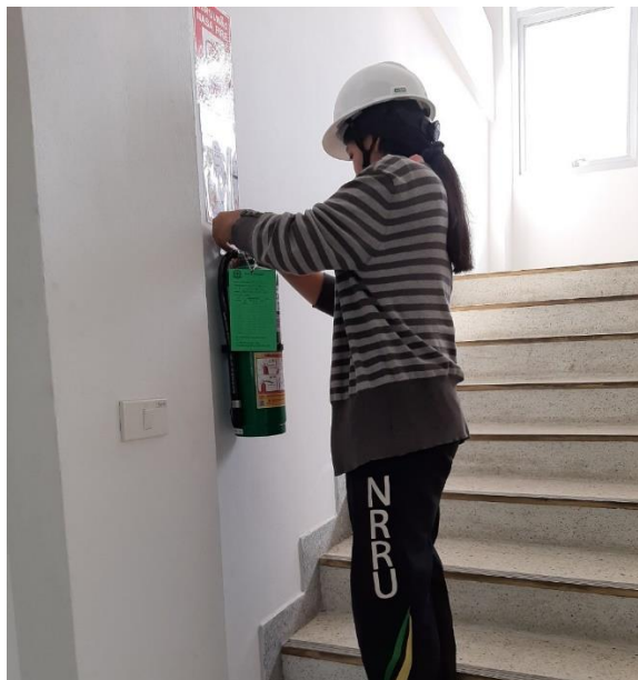
ภาพที่ 1-10 การตรวจถังดับเพลิง
