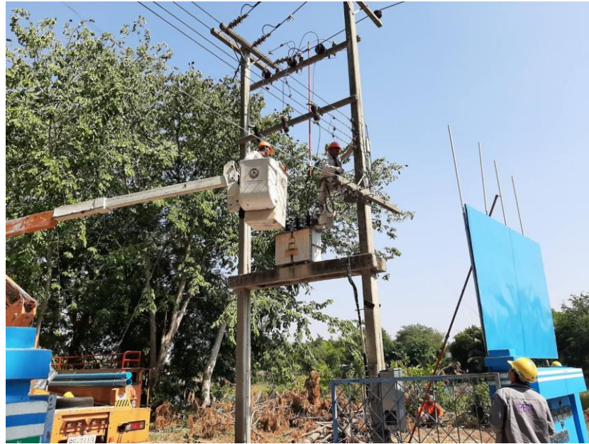
ภาพที่ 1-13 งานบำรุงรักษาหม้อแปลง
