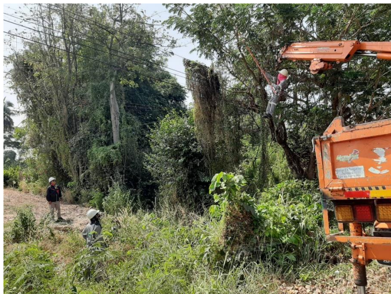
ภาพที่ 1-14 งานพาดสายแรงต่ำ 40 เมตร
