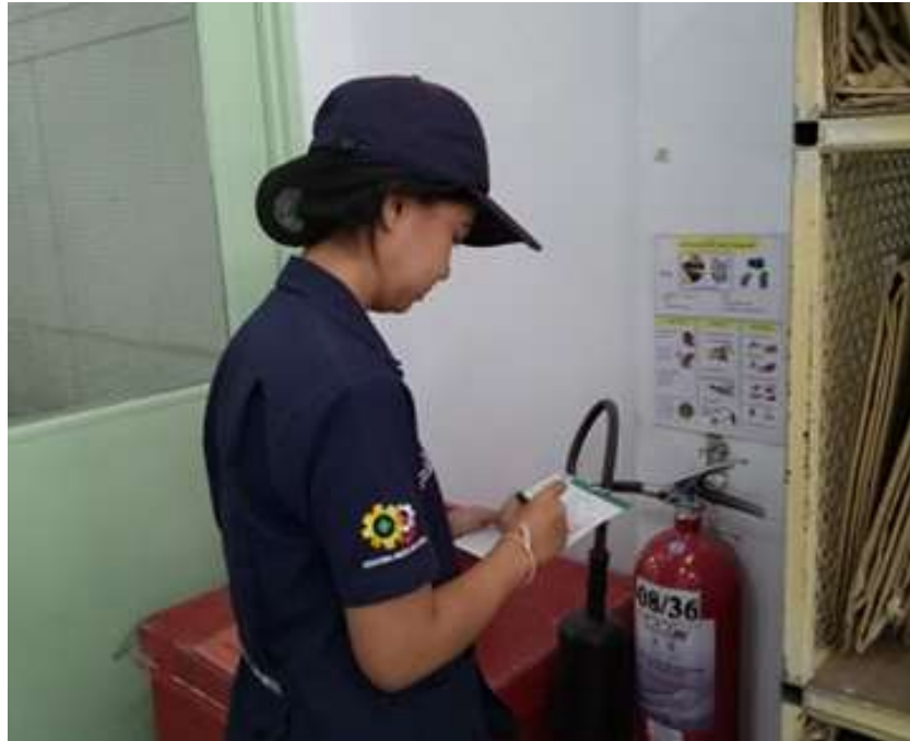
ตรวจเช็คดับเพลิงเป็นประจำทุกเดือน
