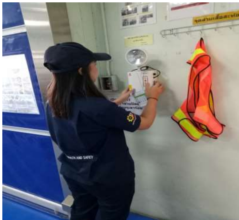
ตรวจเช็คไฟฉายฉุกเฉินเป็นประจำทุกเดือน
