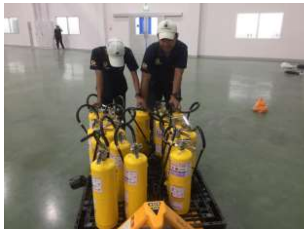
ภาพถ่ายการติดตั้งถังดับเพลิง
