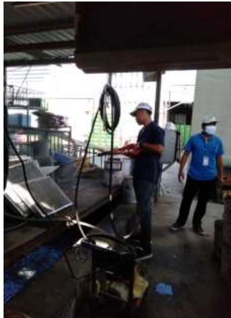
ภาพถ่ายการล้างทำความสะอาดฟิลเตอร์กรองฝุ่น
