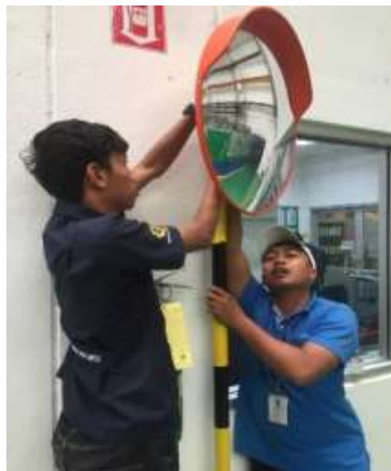
ภาพ 1.9 ติดตั้งกระจกส่องทางแยก
