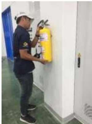
ภาพ 1.8 ติดตั้งถังดับเพลิงใหม่ในโรงแรมนี้เซียม สาขานวนคร
