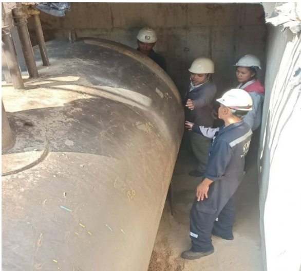
รูปที่ 2.5 ตรวจสอบรอยรั่วของถังบรรจุก๊าซ LPG และที่หัวจ่ายก๊าซภายในปั๊มที่ครบตามวาระ
