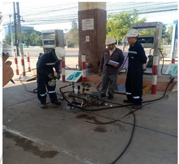
รูปที่ 2.5 ตรวจสอบรอยรั่วของถังบรรจุก๊าซ LPG และที่หัวจ่ายก๊าซภายในปั๊มที่ครบตามวาระ
