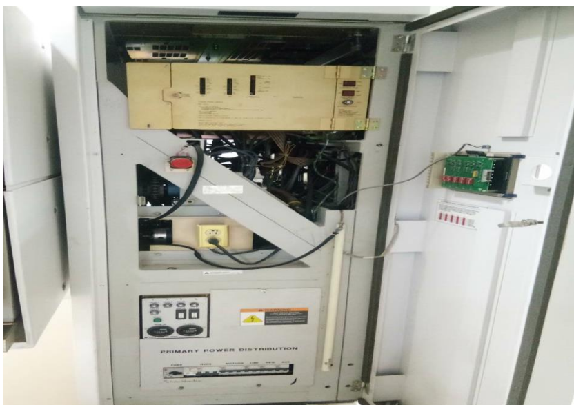
ภาพที่ 3.8 Pulse Modulator
