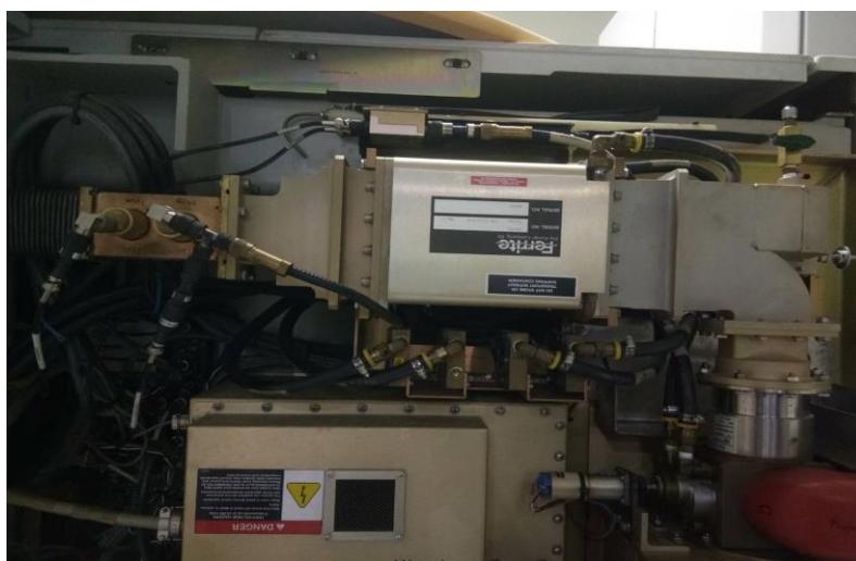
ภาพที่ 3.6 Four port circulator
