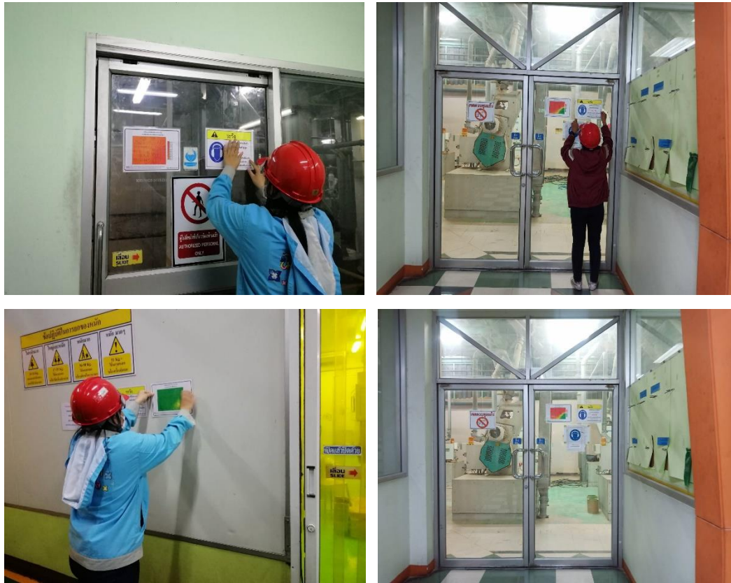
รูปที่ 1.82 ติดป้ายบอกระดับเสียงและเตือนให้ระวังจากเสียงดัง, ป้ายเครื่องหมายเตือนให้ใช้อุปกรณ์คุ้มครองความปลอดภัยส่วนบุคคล, ป้ายแผนผังแสดงระดับเสียง
