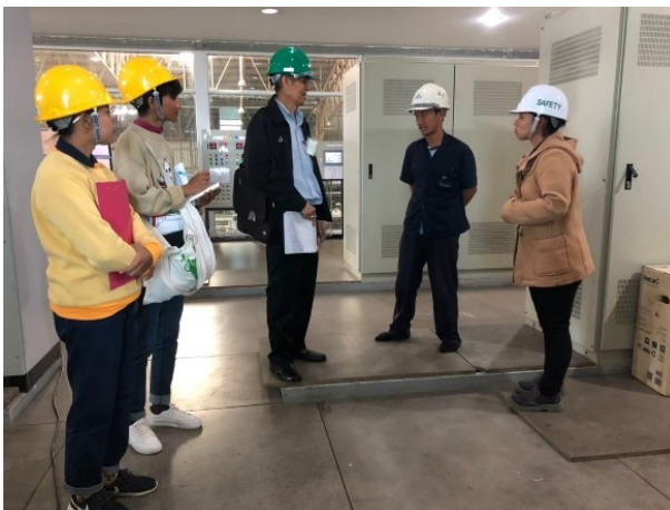
ตรวจระบบไฟฟ้าประจำปี 2562
