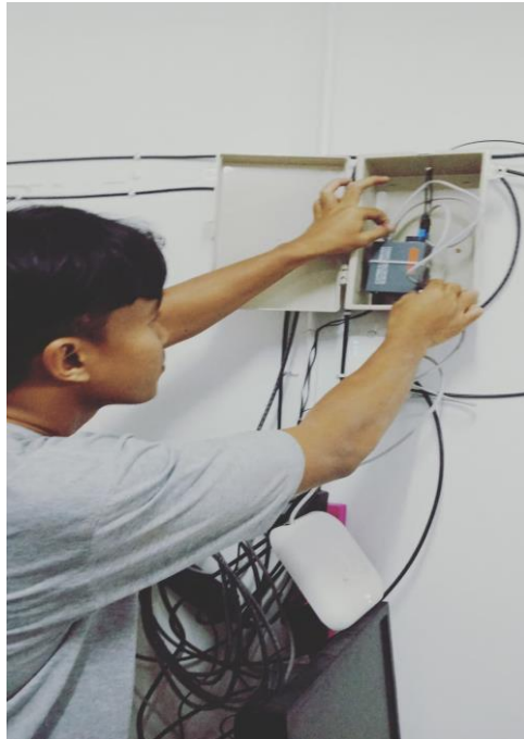
ภาพที่ 8 ติดตั้งสาย Fiber Optic เข้ากับกล่อง Media
