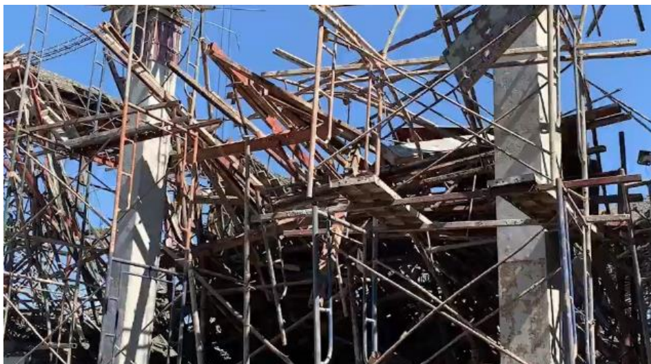
รูปที่ 2-4 การพังทลายของนั่งร้าน (ที่มา scaffoldthai.com)
