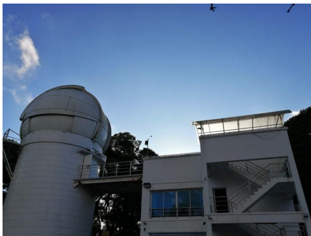
ภาพที่ 1.2 หอดูดาวและอาคารควบคุม
