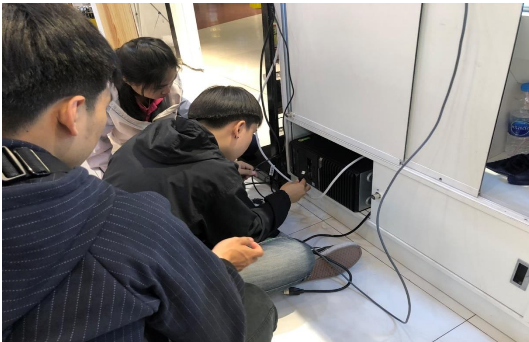
ภาพที่ 4.29 ติดตั้งสาย Lan สาขาเดอะมอลล์
