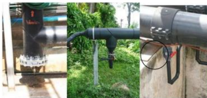
ภาพที่ 2.8 แสดงลักษณะของอุปกรณ์ระบายน้ำแบบ ตัว T และแบบตัว U (ที่มา : กรมโรงงานอุตสาหกรรม. 2553)
