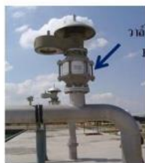
ภาพที่2.5 แสดง Overpressure and Vacuum relief valve และลักษณะการทำงาน (ที่มา : กรมโรงงานอุตสาหกรรม. 2553)
