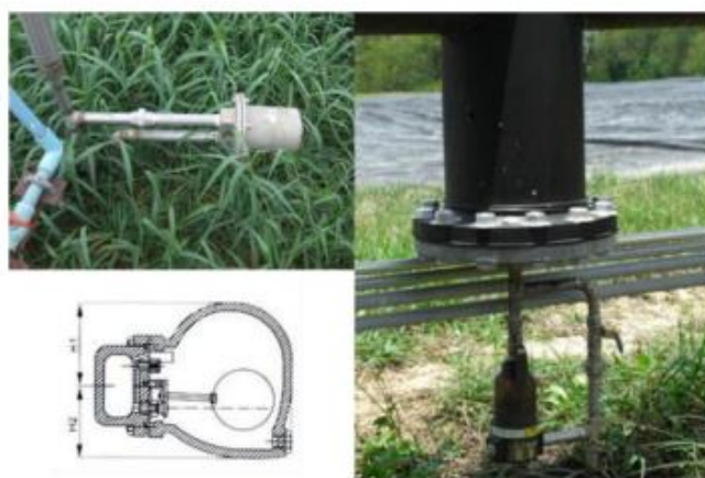
ภาพที่ 2.9 แสดงอุปกรณ์ Auto Drain Valve (ที่มา : กรมโรงงานอุตสาหกรรม. 2553)
