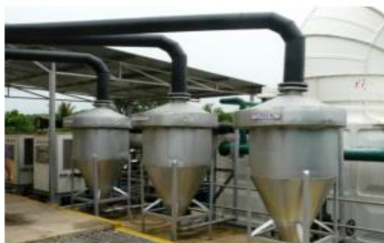
ภาพที่ 2.7 แสดงอุปกรณ์ดักน้ำแบบไซโคลอน
