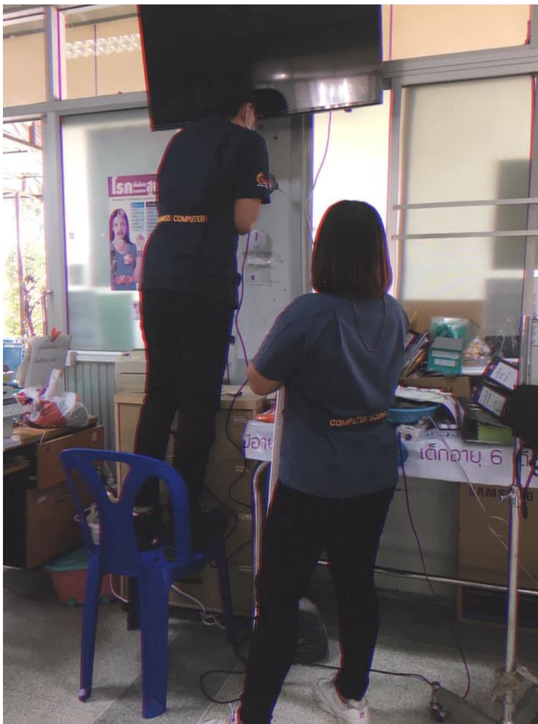
ภาพที่ 9 ติดตั้งเต้ารับ สายแลน พร้อมเก็บสาย
