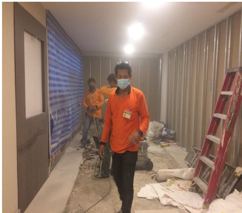
ภาพที่ 14 การตรวจเช็คสถานที่ทำงานก่อนเข้าปรับปรุงพื้นที่
