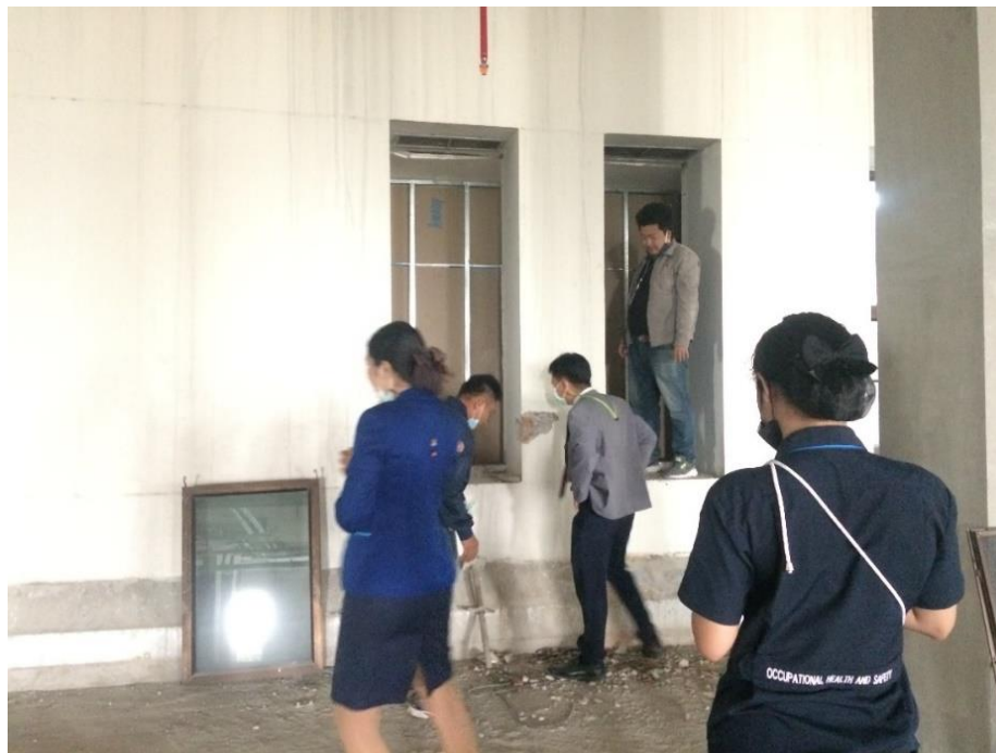
ภาพที่ 2 การตรวจเช็คการทำงานการเจาะผนัง
