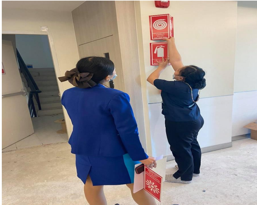
ภาพที่ 12 ภาพการติดตั้งป้ายอุปกรณ์ป้องกันอัคคีภัย
