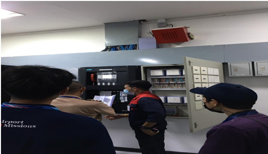
ภาพที่ 1-8 ตรวจสอบระบบแจ้งเหตุฉุกเฉิน
