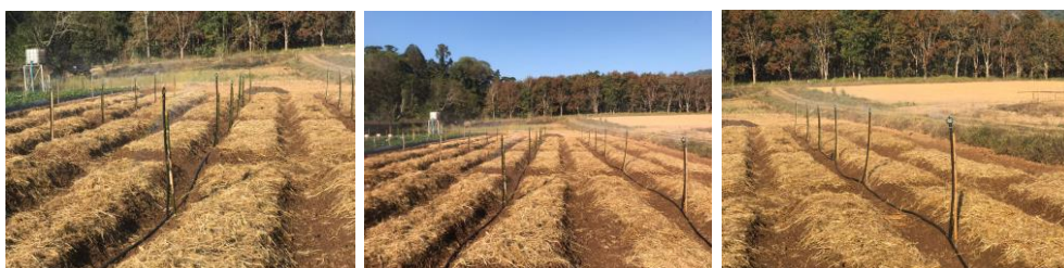
ภาพภาคผนวกที่ 6 ติดตั้งระบบน้ำ
