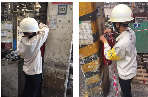
ภาพที่ 19 การตรวจสอบถังดับเพลิงประจำเดือน
