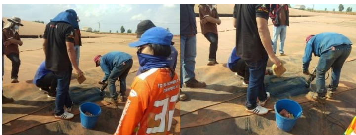
ภาพที่ 1-14 คุมงานผู้รับเหมาซ่อมผ้าใบ Biogas
