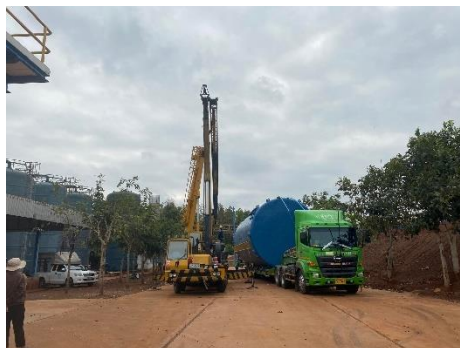
ภาพที่ 1-19 ทีมงานติดตั้งถัง Scrubber ที่ Biogas 3
