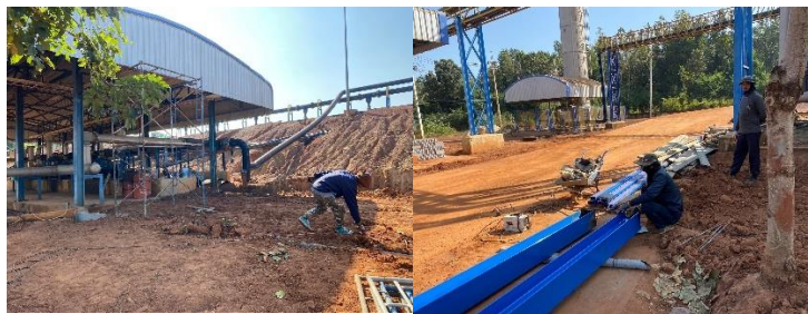
ภาพที่ 1-11 คุมงานเชื่อมโครงหลังคาอาคารโบเวอร์ Biogas 3
