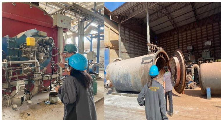
ภาพที่ 1-25 ศึกษากระบวนการทำงานของ Hot oil boiler
