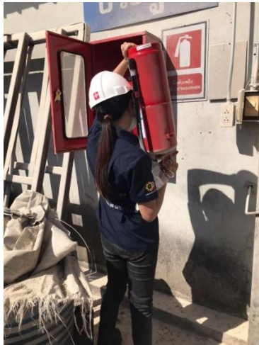
ภาพแสดงการตรวจเช็คถังดับเพลิง และจัดทำบันทึกการตรวจถังดับเพลิง
