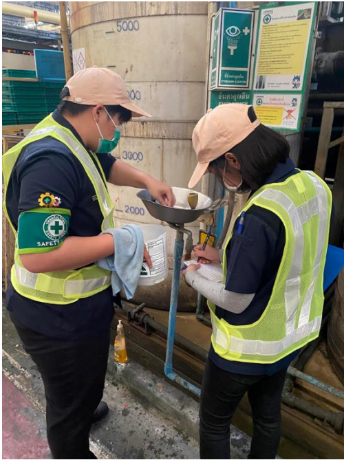
ตรวจสอบและทำความสะอาดอ่างล้างตาฉุกเฉิน
