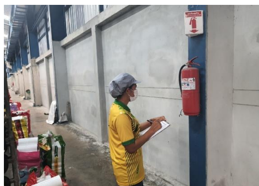
ภาพที่ 1.12 ตรวจสอบสภาพถังดับเพลิงประจำวัน
