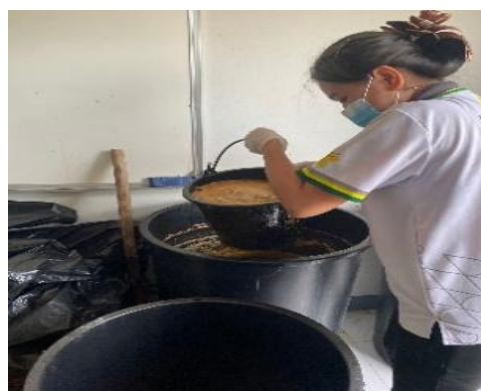
รูปที่ 3.36 ได้รับมอบหมายงานให้นำ EM เติมลงในบ่ออากาศของระบบบำบัดน้ำเสียอาคารสุรนารี
