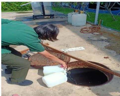
รูปที่ 3.37 ได้รับมอบหมายงานให้ศึกษาเรียนรู้ตรวจค่า TDS, ค่าpH ในบ่อเติมอากาศและเติมคลอรีนลงในบ่อสัมผัสคลอรีน
