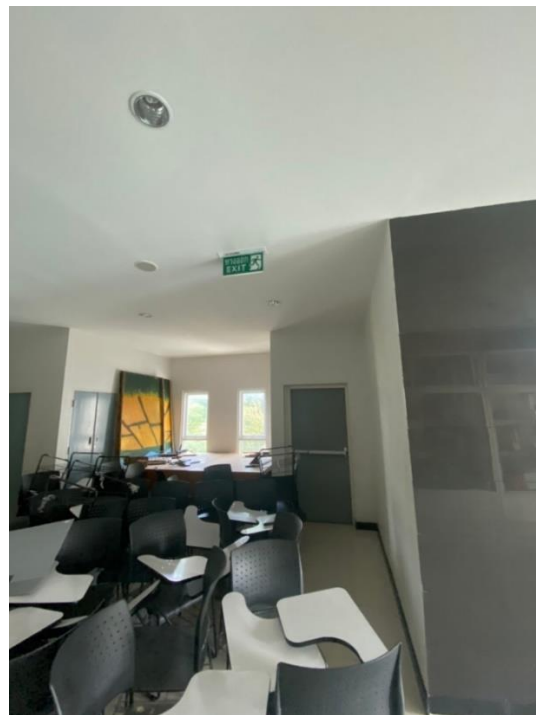
ภาพประกอบที่12 ประตูทางออกฉุกเฉิน(มีสิ่งกีดขวาง)
