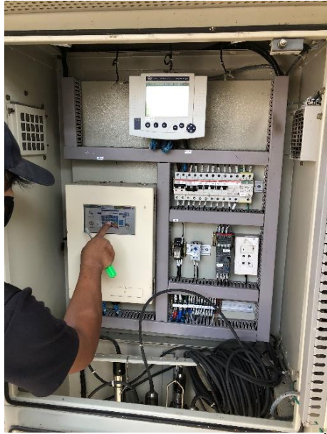
ภาพที่ 2.6 ตรวจสอบสถานีตรวจวัดคุณภาพน้ำอัตโนมัติ สถานีประตุน้ำบ้านกันผม
