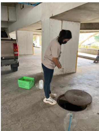
อาคารชุดซิลเวอร์บิซ คอนโดมิเนียม
