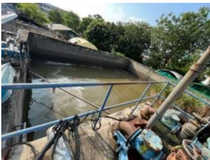
รูปที่ 1 บ่อปรับสภาพน้ำเสีย (Equalization Tank)
