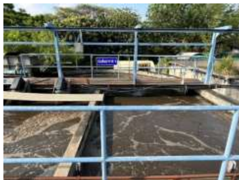
บ่อเติมอากาศ 1
