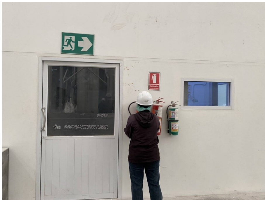
ตรวจถังดับเพลิง
