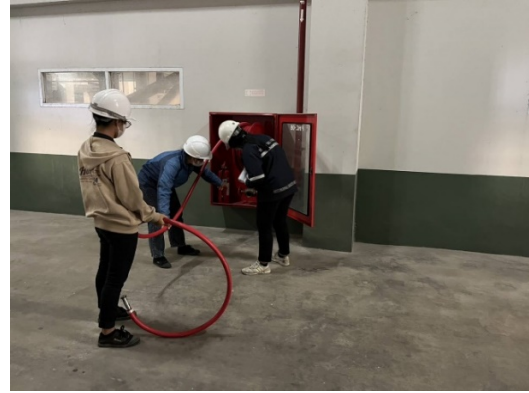
ภาพการตรวจเช็คตู้สายฉีดน้ำดับเพลิง
