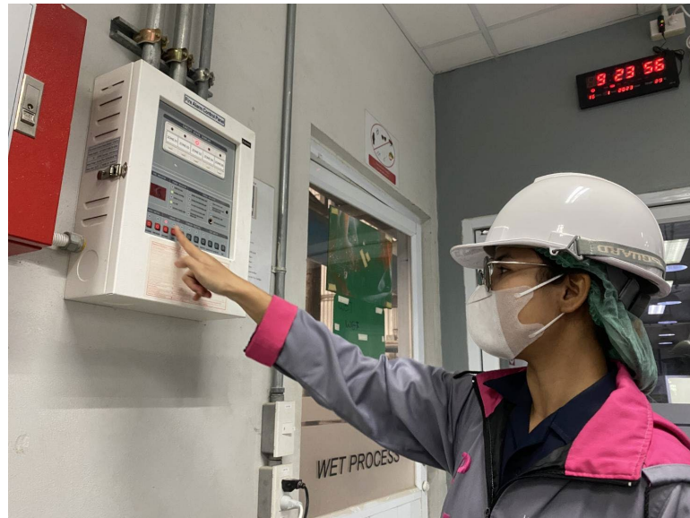
ภาพการตรวจเช็คระบบไฟอราม
