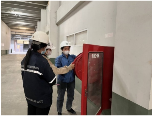
ภาพการตรวจเช็คตู้สายฉีดน้ำดับเพลิง
