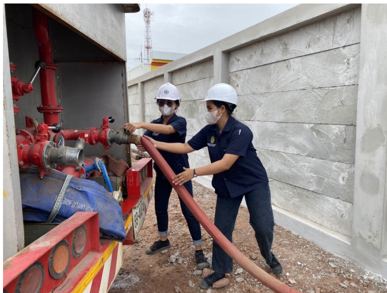
ภาพการศึกษาระบบการจ่ายน้ำกับรถน้ำดับเพลิง
