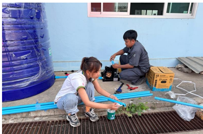
ซ่อมท่อน้ำ
