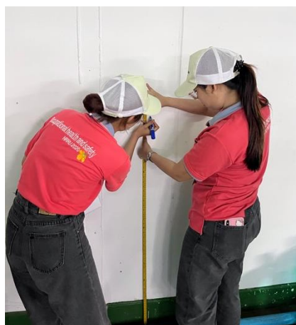
ติดตั้งถังดับเพลิง
