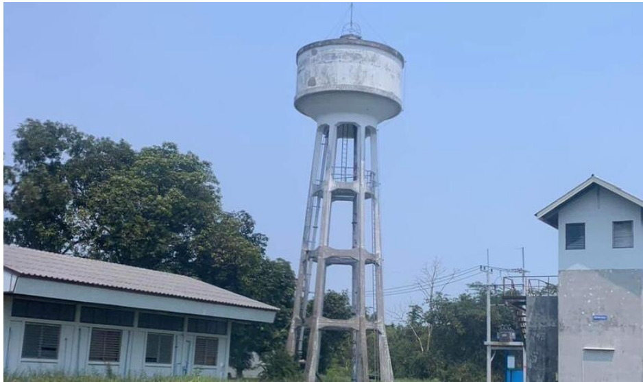
ภาพที่ 3.8 หอถังสูง
