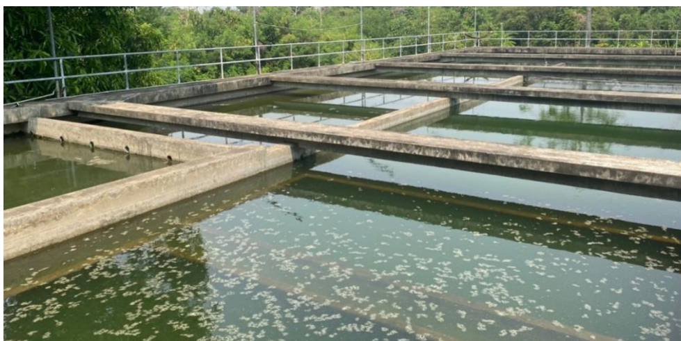
ภาพที่ 3.4 บ่อรวมตะกอนและเติมสารส้ม
