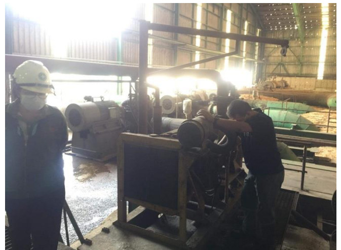
ลงพื้นที่ตรวจสอบปั้มน้ำดับเพลิง
