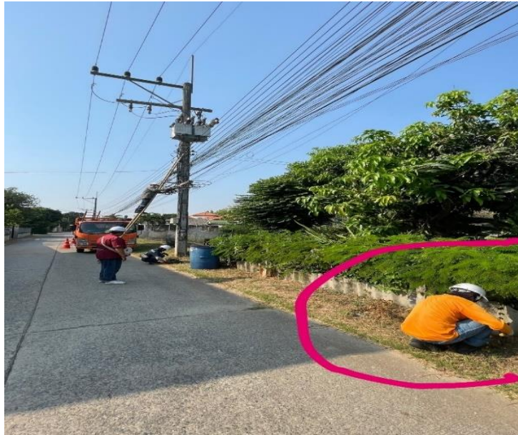
รูปที่ 3.7 การปักแท่งเหล็กลงดิน
