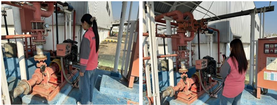
ภาพที่ 1-11 ทดสอบระบบปั้มน้ำดับเพลิง
