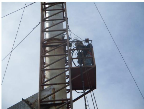
ภาพที่ 3 บริการตรวจวัดคุณภาพอากาศจากปล่องระบายอากาศ (Stack Emission)
