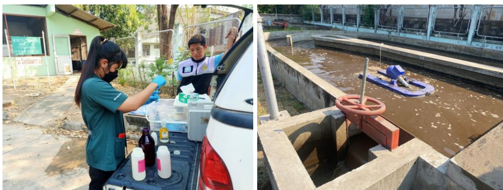
รูปที่ 2.31 ภาพการตรวจระบบบำบัดน้ำเสียของโรงพยาบาลโคกสำโรง จังหวัดลพบุรี
