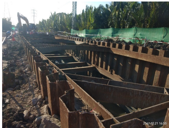
ภาพที่ 3.9 การก่อสร้างเตรียมบ่อรับสำหรับการติดตั้งเครื่องดันลวดท่อส่งก๊าซธรรมชาติ
