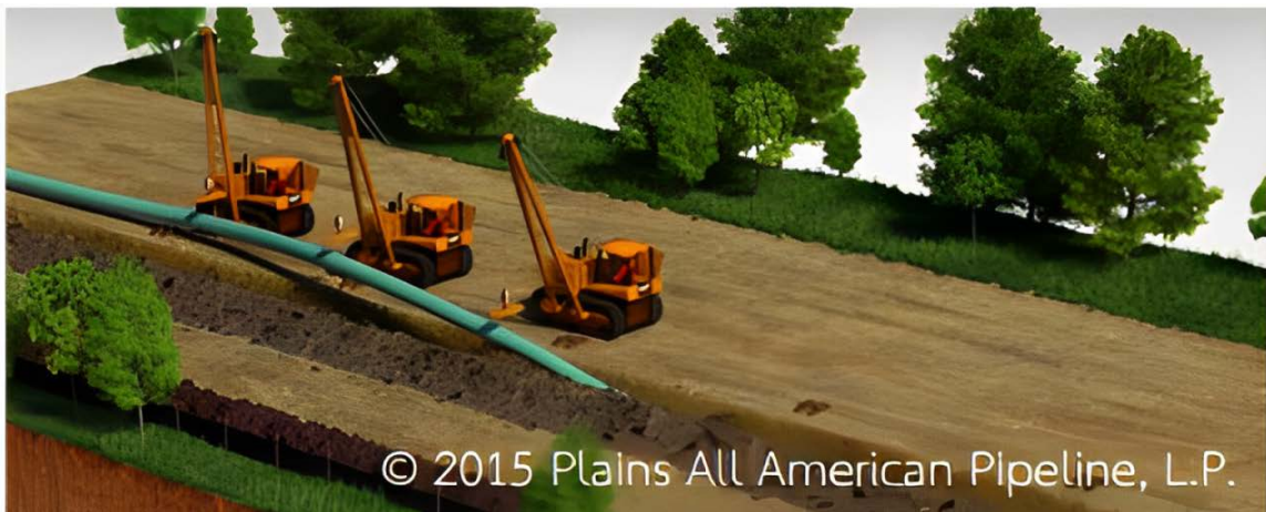
ภาพที่ 3.3 การวางท่อแบบขุดเปิด (Open cut)
