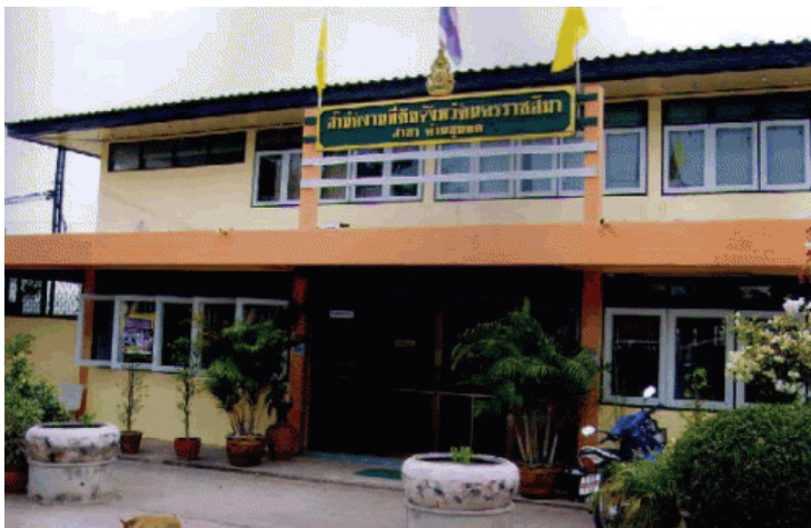
รูปภาพที่ 1.1 กรมที่ดินจังหวัดนครราชสีมา สาขาด่านขุนทด
