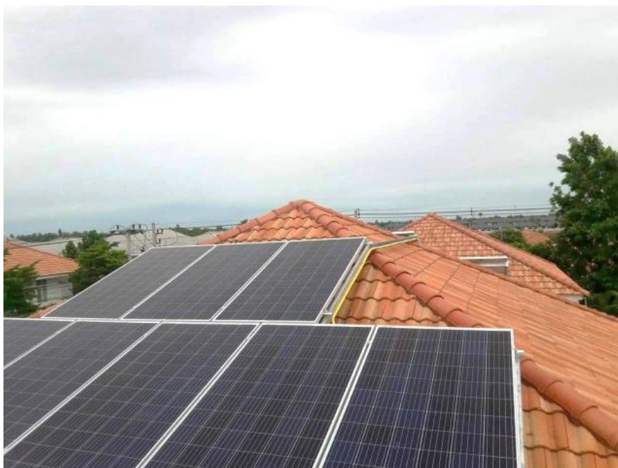
ภาพที่ 4.4 ติดตั้งแผงเซลล์แสงอาทิตย์และสายไฟ
