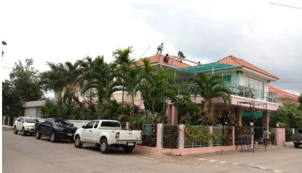
ภาพที่ 4.2 ติดตั้งโครงเหล็กเพื่อจับยึดแผงเซลล์แสงอาทิตย์
