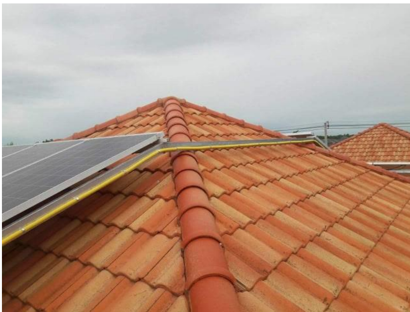
ภาพที่ 4.3 โครงเหล็กจับยึดแผงเซลล์แสงอาทิตย์
