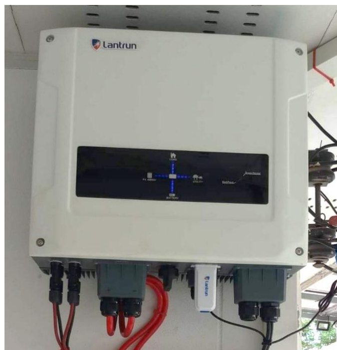
ภาพที่ 4.6 ตู้แปลงไฟฟ้าระบบไฮบริด
