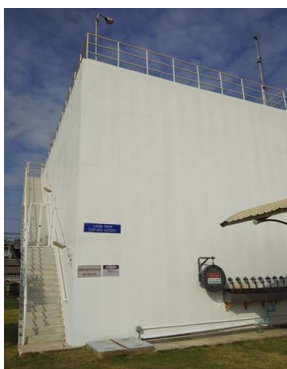
รูปที่ 2.11 แสดงบ่อบำบัดน้ำเสียแบบไร้อากาศ (Up-flow Anaerobic Sludge Blanket, UASB Tank)
