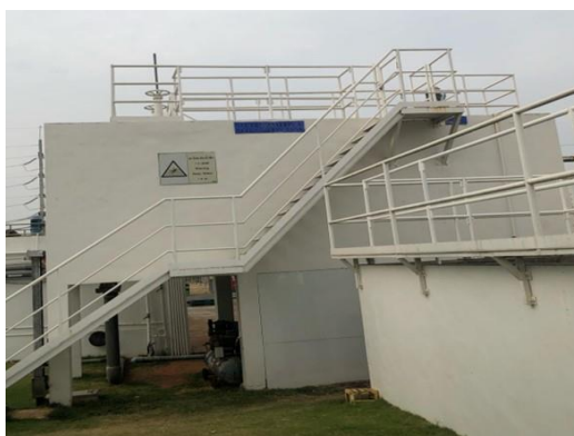
รูปที่ 2.10 แสดงบ่อเติมสารอาหาร (Neutralization & Attenuation Tank)
