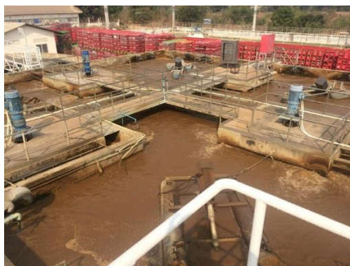
รูปที่ 2.12 แสดงบ่อบำบัดน้ำเสียแบบเติมอากาศ (Aeration Tank)
