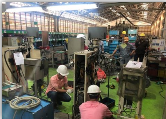
รูปภาพที่ 27 ตรวจสอบความปลอดภัย อาคารโรงงาน 2 ในการ Overhaul
