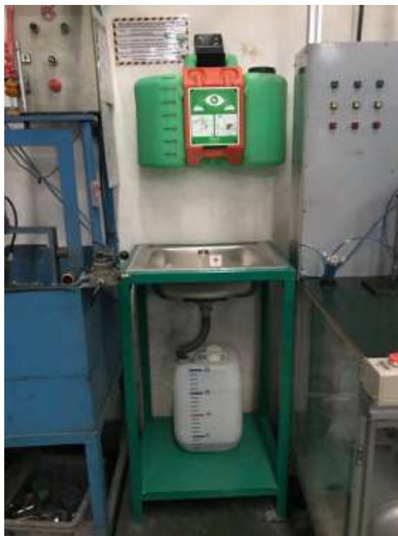
รูปภาพหลังการดำเนินการจัดทำฐานรองรับน้ำ บริเวณแผนกเครื่องมือกล
