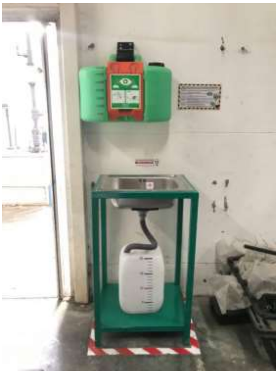
รูปภาพหลังการดำเนินการจัดทำฐานรองรับน้ำ บริเวณแผนกซูป
