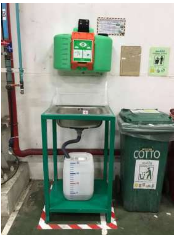
รูปภาพหลังการดำเนินการจัดทำฐานรองรับน้ำ บริเวณแผนกประกอบ
