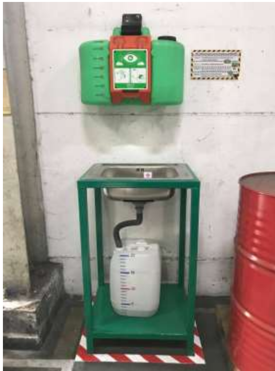
รูปภาพหลังการดำเนินการจัดทำฐานรองรับน้ำ บริเวณแผนกหล่อ
