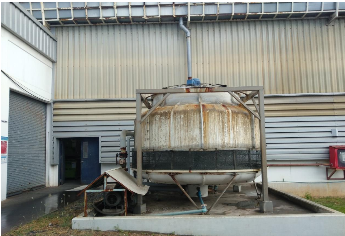
ภาพที่ 3.16 วิเคราะห์งานเพื่อความปลอดภัยแผนก Boiler
