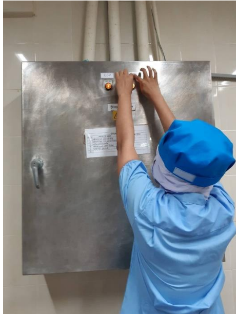
เดินสำรวจในโรงงานและนำป้าย บอกกำลังไฟฟ้า ไปติดที่ตู้ควบคุมไฟฟ้า
