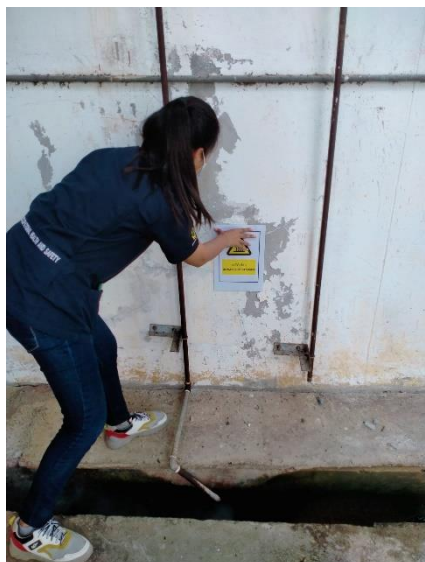
ติดป้ายแสดงความเป็นอันตรายบริเวณท่อระบายไอน้ำร้อน
